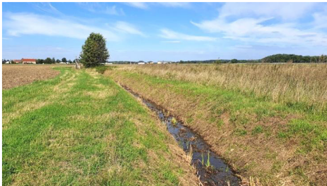
Typische Ausprägung eines Gewässers im Gemeindegebiet: Der Gewässerlauf ist als regelmäßiges Trapezprofil ausgebaut worden, begradigt und fast gehölzfrei. Um den Ausbauzustand zu erhalten, werden Ufer und Gewässersohle intensiv freigemäht / geräumt. Einheimische Tiere und Pflanzen finden kaum Lebensraum, die gesetzlichen Anforderungen werden nicht erfüllt.
